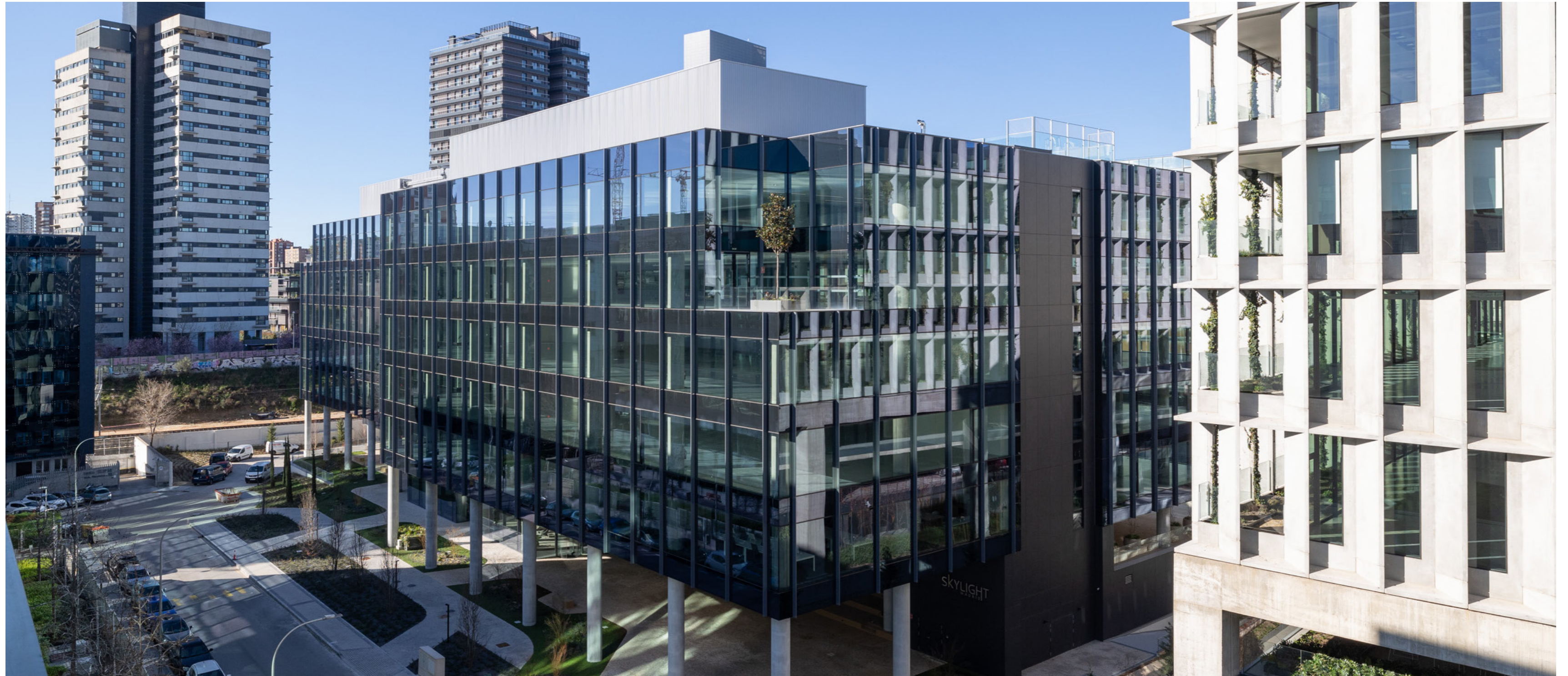
Fachada frontal - Av. Manoteras 14-16
